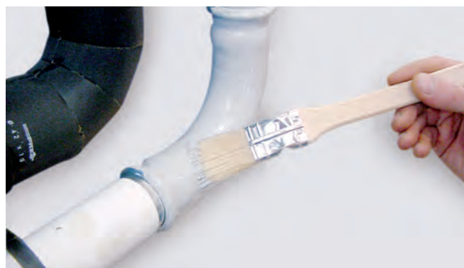
Figura 42 - Verniciatura raccordi e tubazioni con primer
