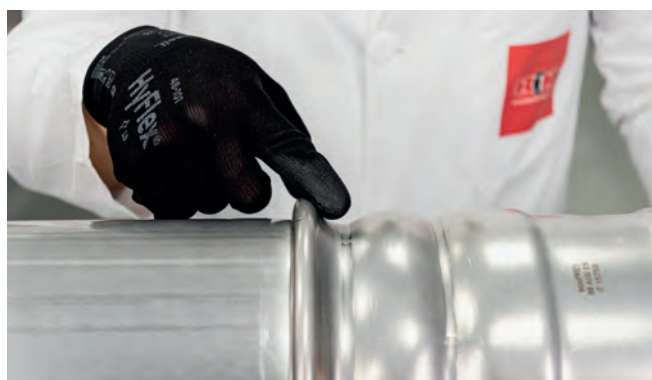
Figura 41 - Controllo visivo pressatura Oversize
