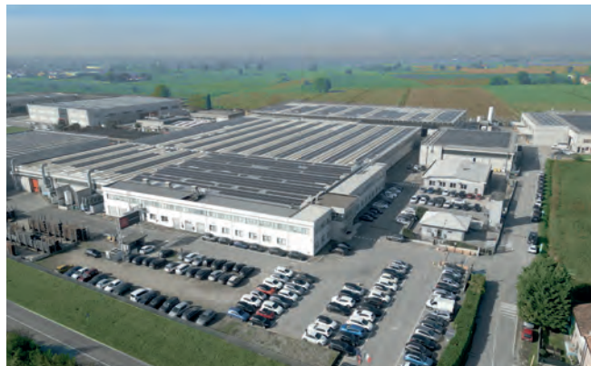
Figura 1 – Sede e stabilimento a Campitello
