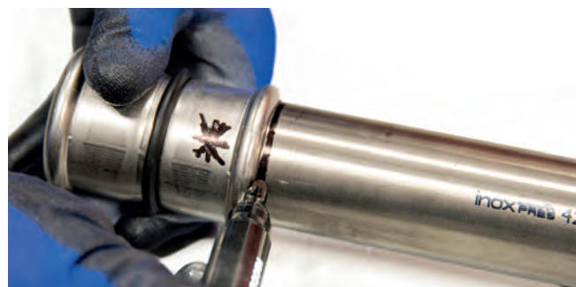
Figura 32 – Marcatura della profondità d'innesto con raccordo
