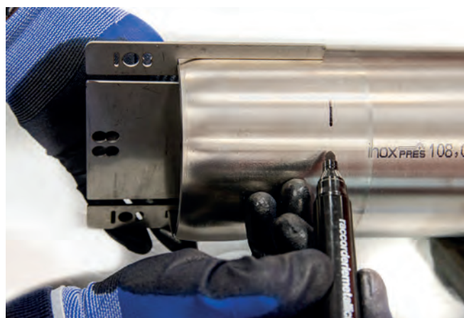
Figura 29 – Marcatura della profondità d'innesto con marcatore Ø 76 mm - Ø 88 mm - Ø 108 mm
