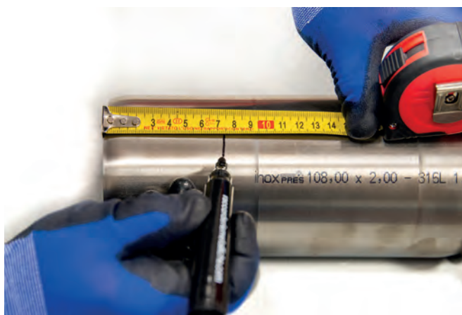
Figura 28 – Marcatura della profondità d'innesto con metro
